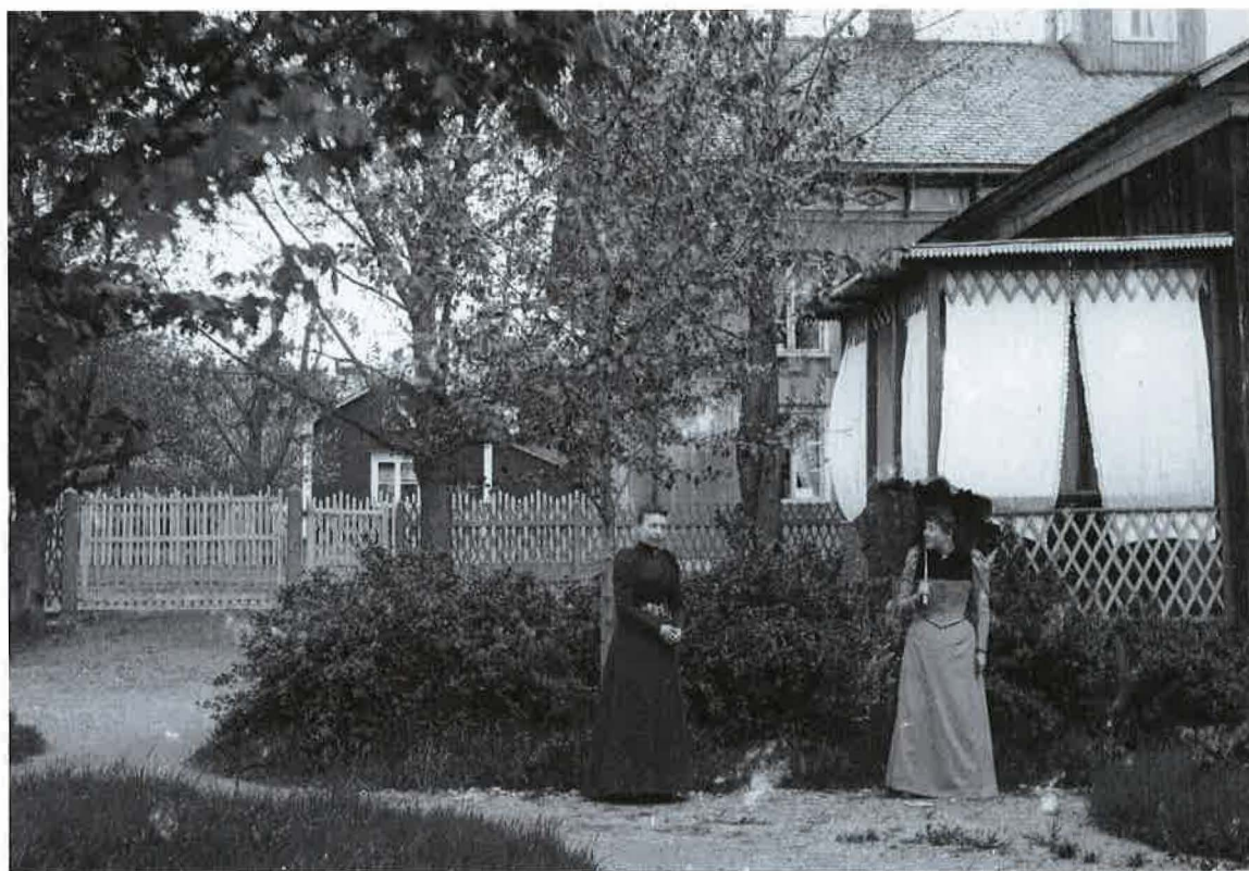
Innergården till Köpmangatan 7 där Amelie Rydberg bodde och hade sin ateljé.
